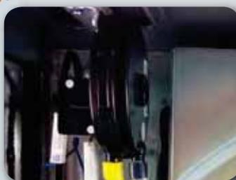
Все котлы ROC оборудованы 2-х канальным прессостатом, не подверженным замерзанию (корпус из пластика без металлических частей) и контролирующим не просто факт работы вентилятора, а реальную ситуацию с дымоотведением – 100% безопасность!
