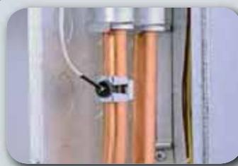
В котлах ROC используются накладные быстросъемные температурные датчики NTC, не имеющие контакта с водой и теплоносителем, поэтому они не покрываются накипью и не выходят из строя даже в тяжелых условиях эксплуатации.
